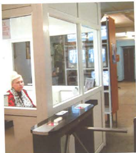
Вахты оборудованы электронно-пропускной системой
