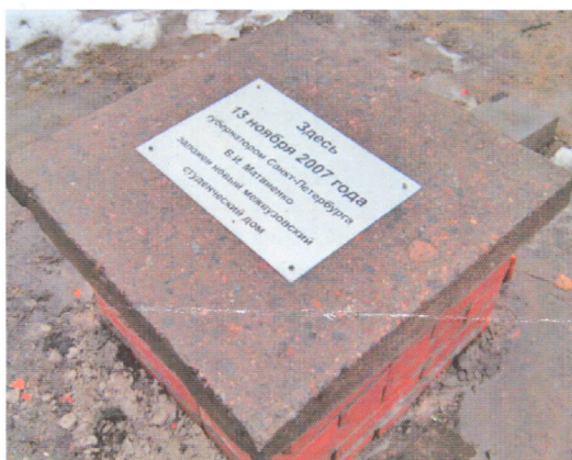
Здесь по решению Губернатора СПб В.И. Матвиенко начато строительство современного студенческого дома
